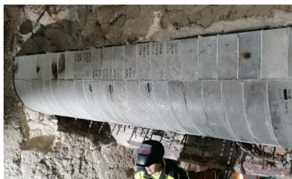
Obr. 11 Zavěšené tvarovky bull nosu, realizace únor 2022
