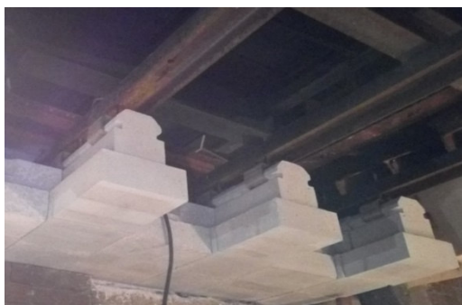
Obr. 9 Tvarovky zavěšeného stropu chladiče - na horním snímku návrhová skladba, na dolním snímku instalace tvarovek v únoru 2019
