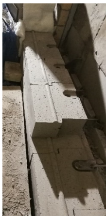
Obr. 8 Tvarovky bočních stěn - na snímku vlevo je skladba tvarovek, na snímku uprostřed hotová sestava stěny, na snímku vpravo detail opotřebení stěny po roce provozu v únoru 2022
