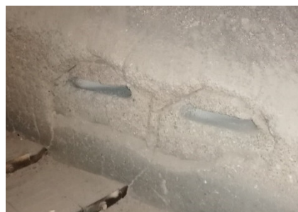
Obr. 7 Tvarovky trysek vzduchových děl - na levém snímku je model tvarovky, na pravém snímku pak zabudované tvarovky po roce provozu v únoru 2022
