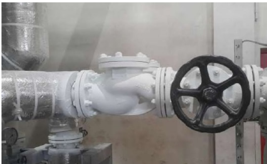
Obr. 4 Izolácia armatúry náterom PSC-250T/HP a PSC-250T/EC, čo spôsobilo zníženie unikajúceho tepla z armatúry o viac ako 30 %
