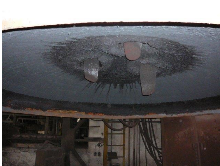
Obr. 3 Detailní pohled na monolitickou vyzdívku víka EOP
