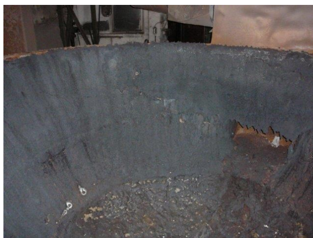
Obr. 4 Pohled na boční stěny a dno EOP z monolitu tvořeného UŽH
