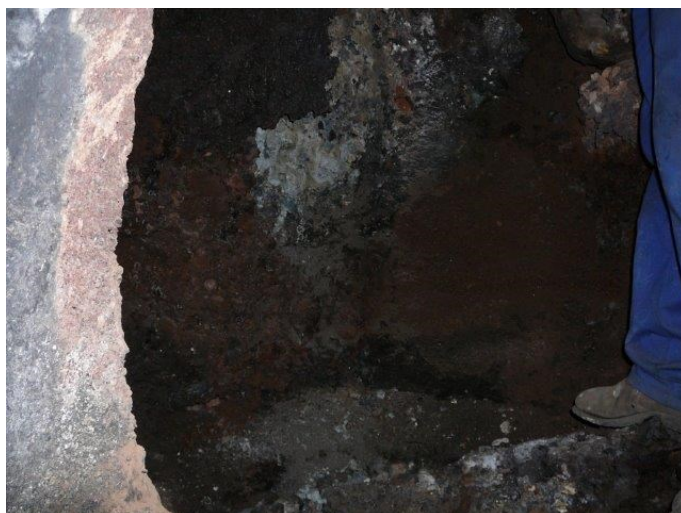
Obr. 6 Pohled do nístěje kupolní pece před opravou hmotou UŽH-D
