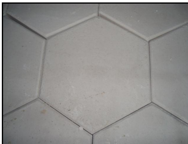
Obr. 4 Šestiúhelníková tvarovka z IZOLANU C
