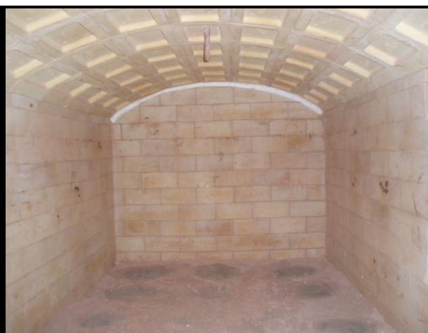
Obr. 5 Vyzdívka komorové pece IZOLANEM C
